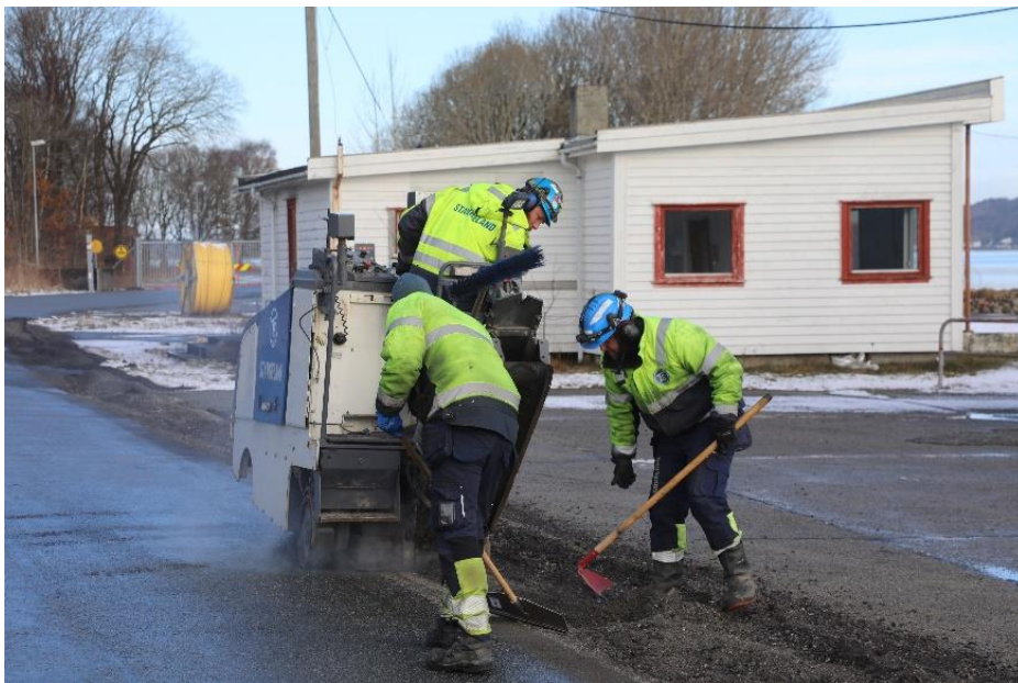
Asfalt må kuttet for å legge kablene i ny grøft
