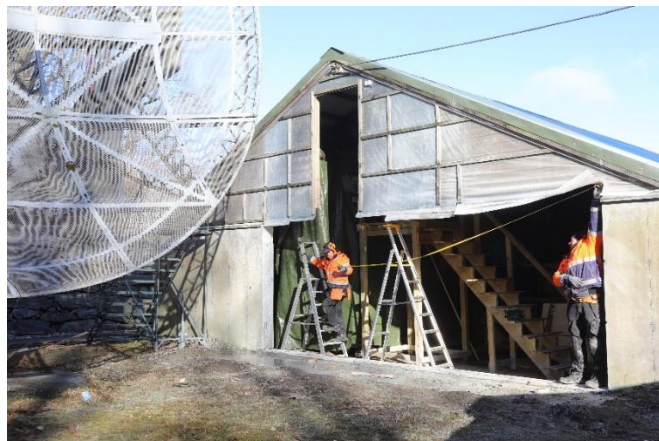
Åpning av vegg i tank
