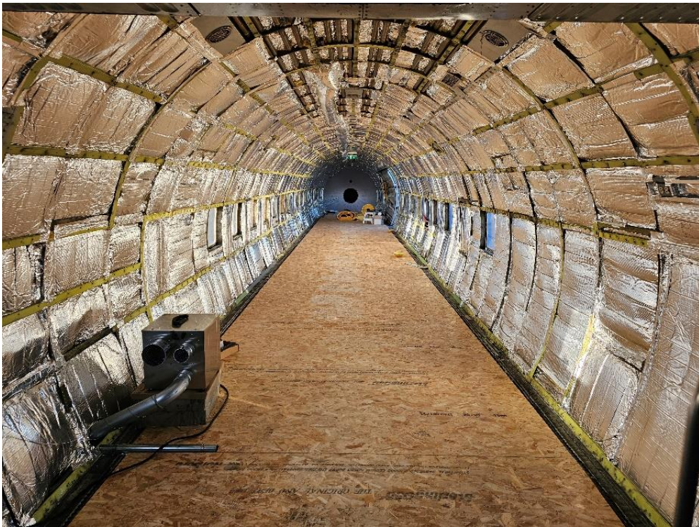
Kabinen i DC 6 ferdig isolert.
