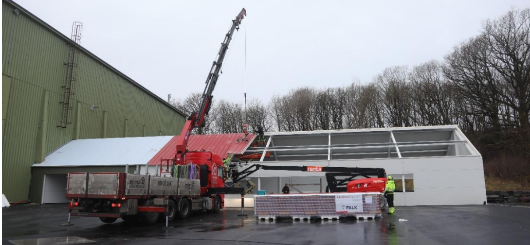
Montering av takplater på foajebygget.
