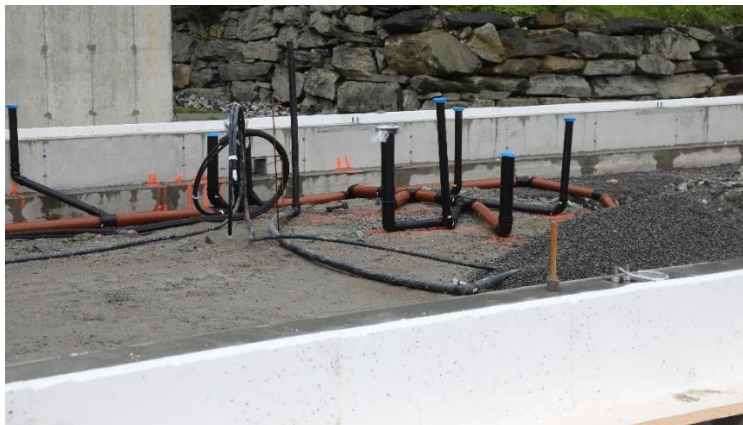
Grunnmuren støpt, og det arbeides med legging av rør i gulvet
